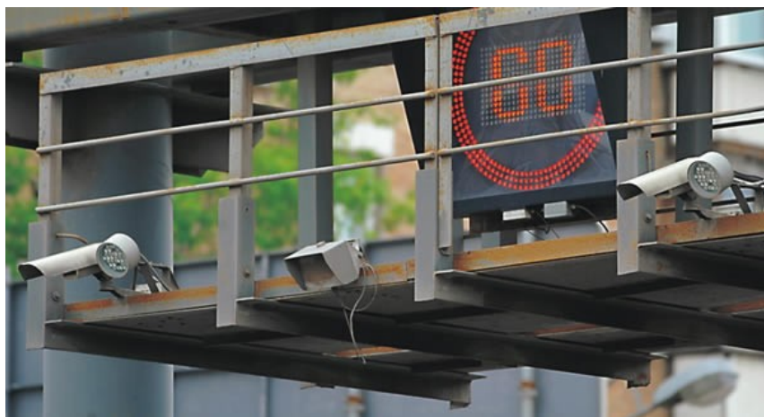
Рис.П7 - Размещения камер системы распознавания номеров на арке.
